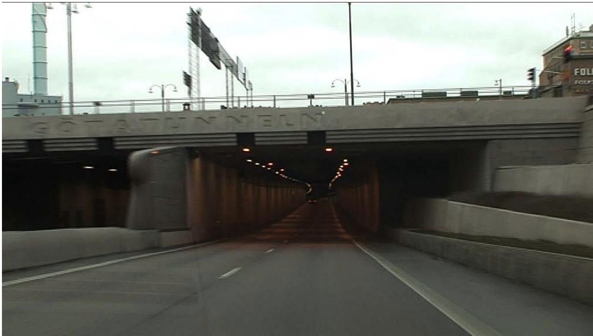
Götatunnelns infart från Järntorget.
